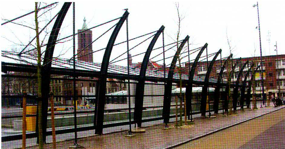
Ein Projekt so recht nach dem Geschmack von Staalmeesters: Spantenüberdachung einer Tiefgaragenausfahrt
